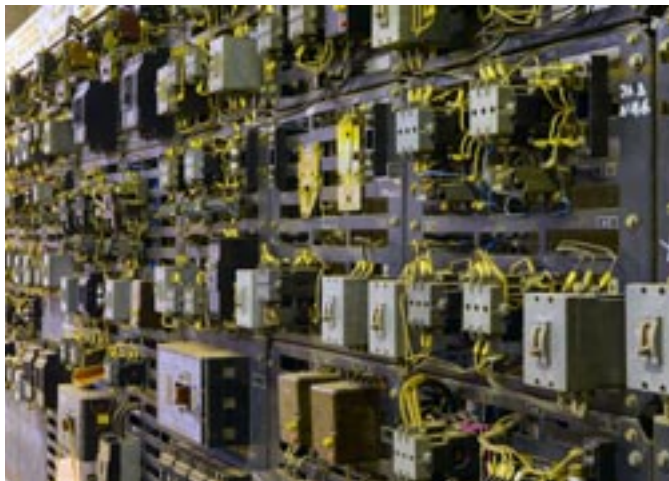
Nettoyage de contacts électriques avec technique dite "sèche"
